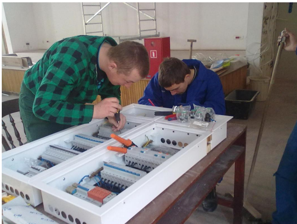
Ryc. 5 Uczniowie szkoły zawodowej realizujący praktykę w CKP we Włocławku podczas montażu rozdzielnic na obiekcie budowlanym
